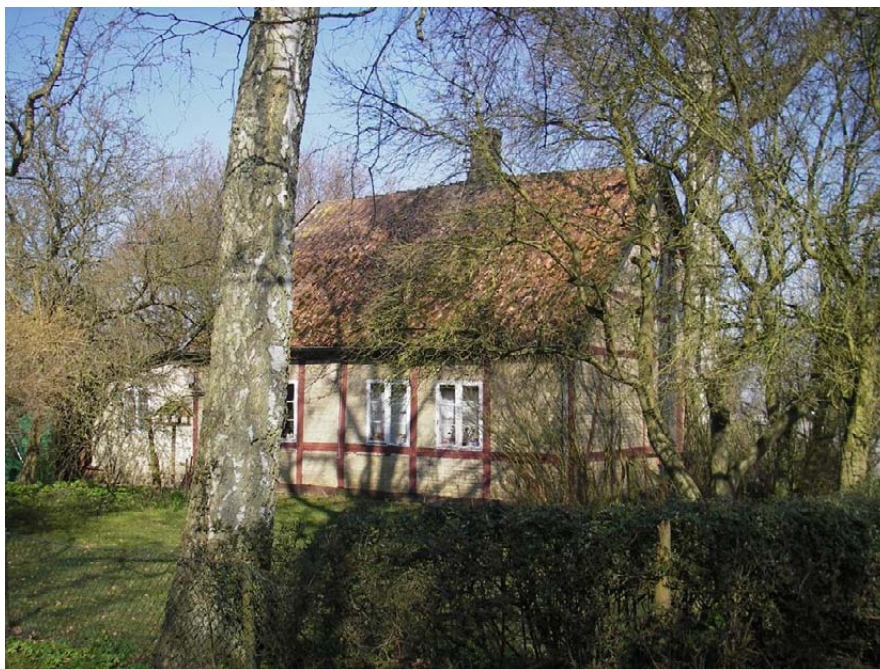
Flårupmelle: På hjørnet af Keldskovvej og Flårupvej ligger et af de huse, der blev bygget omkring 1890. I dag fremstår mange af disse bygninger, der oprindeligt er opført i tegl, vandskurede eller pudsede med gul eller grå farve. Man bør derfor være opmærksom på at bevare enkelte huse med den oprindelige facadebehandling.
