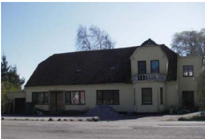
Bygningen nedenfor ligger umiddelbart overfor præsteboligen.
