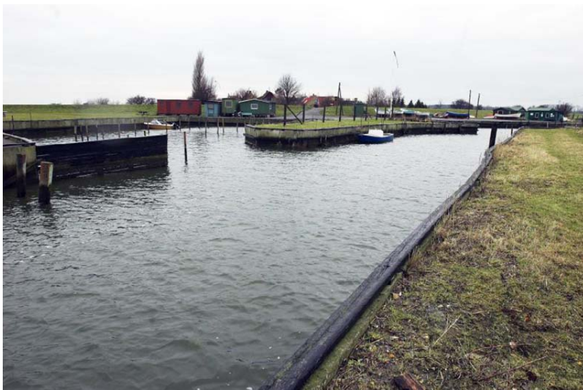
Errindlev Havn fra starten af 1900-tallet har to havnebassiner. Lige bagved diget skimtes toppen af de huse, som i løbet af 1900-tallet er blevet bygget på Havnevejen. Foto Jan Steving, 2007.
