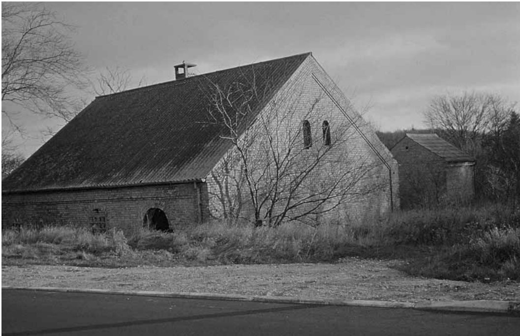
Pumpestation ved Hasselø
